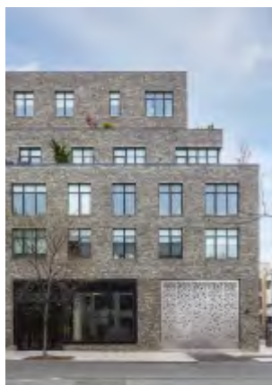
31 505 Pacific Street, Brooklyn Arkitekt: Beyer Blinder Belle Architects Færdiggjort: 2018 Sten: D92 DNF Foto: Dean Kaufman Se omtale side 7
