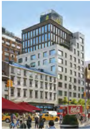
06 345 West 14th Street, Manhattan Arkitekt: DDG Partners Opført: 2017 Sten: K91, D91 FF Foto: Tom Eckerle Se Petersen magasin nr. 29
