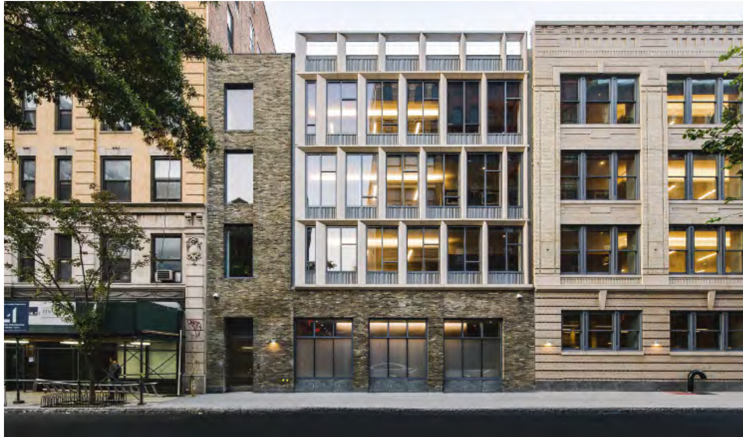
Den nye bygning er opført i D54, hvis rige farvespil fanger alle nuancer i de to nabobygninger, der har facader i henholdsvis mur, kalksten og puds.
